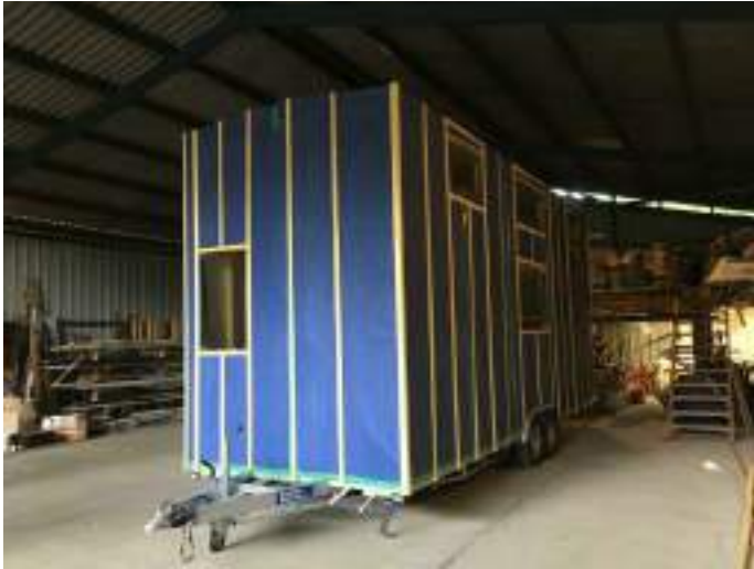
Le pare-pluie posé sur les façades
