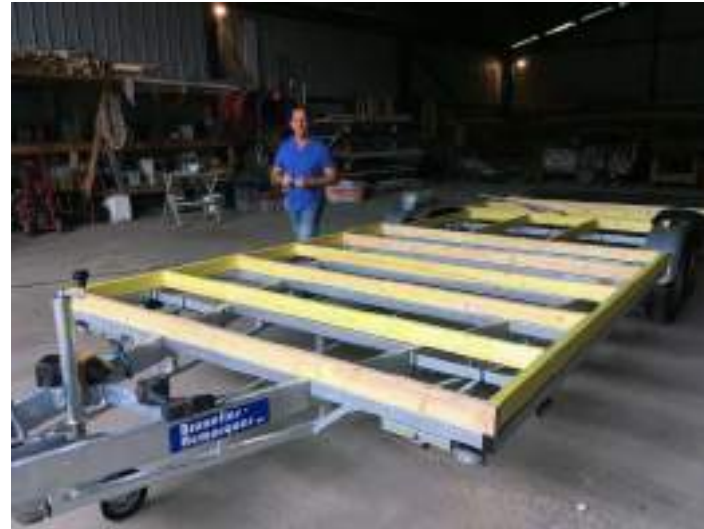
L'ossature du plancher en cour de montage
