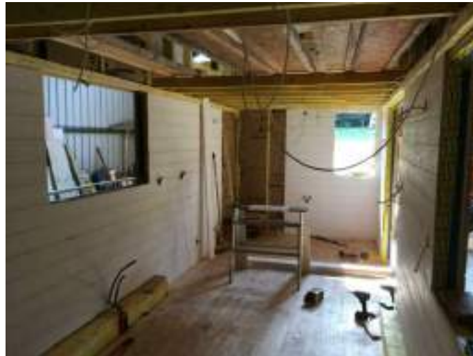
Le lambris intérieur en cours de pose
