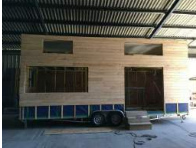
Le bardage bois posé sur les façades
