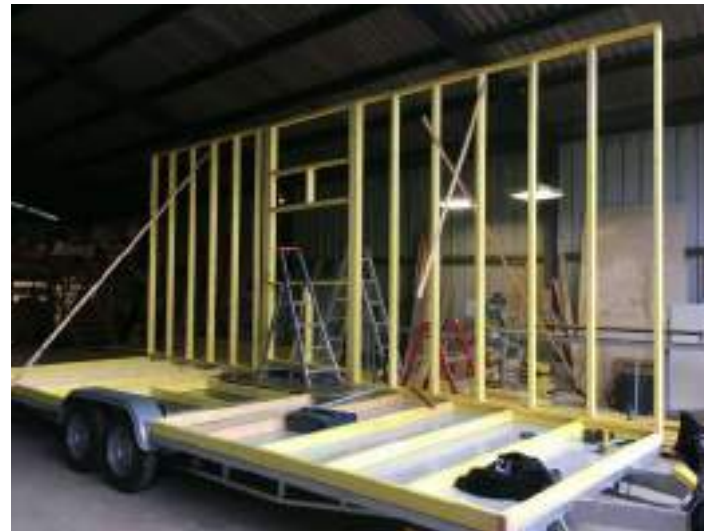
L'ossature des murs en cour de montage
