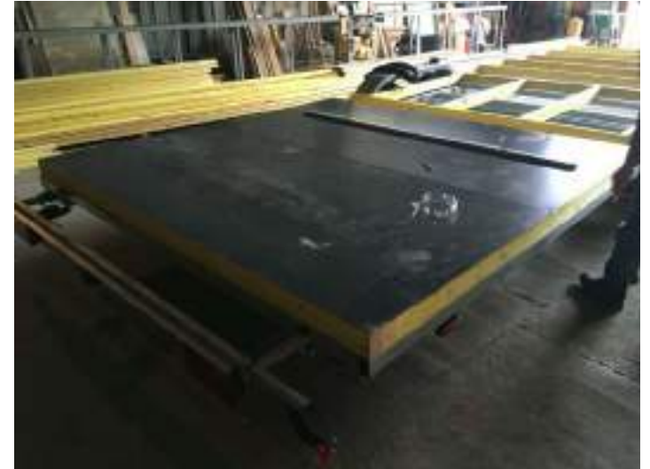
La sous-face du plancher en tôles
