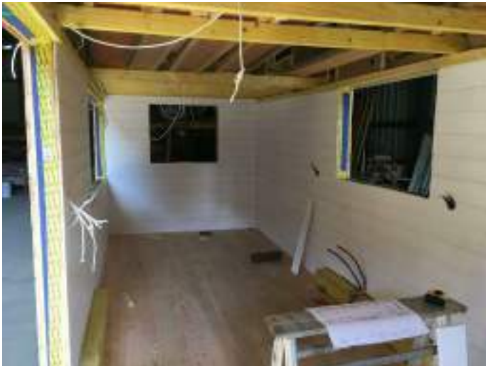
Le lambris intérieur en cours de pose
