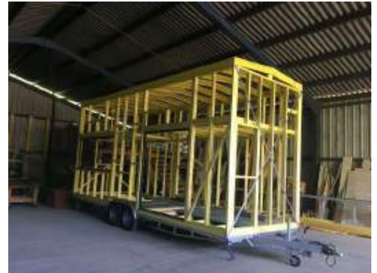
L'ossature des murs et du toit finie
